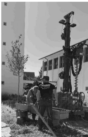
Meter um Meter in die Tiefe: Brunnenbohrarbeiten am 18. und 19. August.
